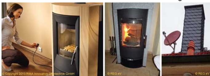
Bild (v. li. nach re.): Kaminofen fertig zum Anheizen und in der Heizphase, Schornstein alt für Kamin und neu für Gasheizung
